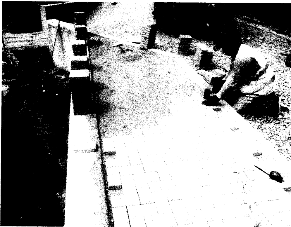
Figura N°04. Piso Adoquinado, en zona de recepción y gradas
